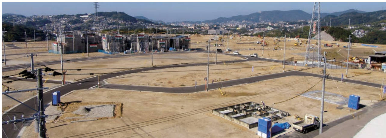
宅地完成工事が進む住宅団地「グランアヴェニューひうみ」
