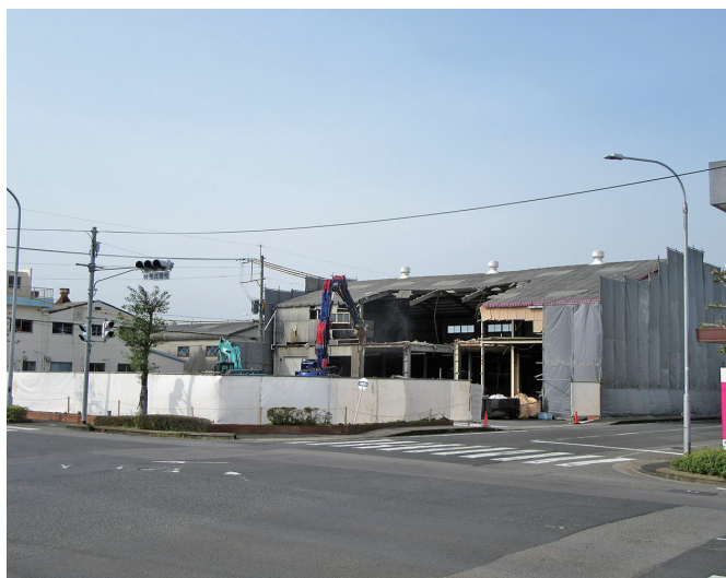
解体中の旧和信産業物流センター建物
